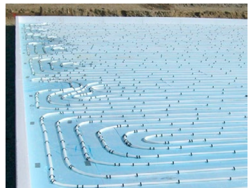
Darüber kommen die endlos verlegten 5-Schicht Verbund-Heizrohre.
