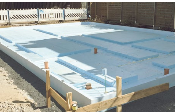
Hochgedämmte Bodenplatte in Polystyrol Hartschaum (XPS), zugelassen zum Einsatz unter statisch tragenden Bodenplatten.
