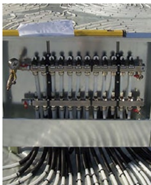
Über den Heizkreisverteiler regeln Sie für jeden Raum Ihre Wunschtemperatur.
